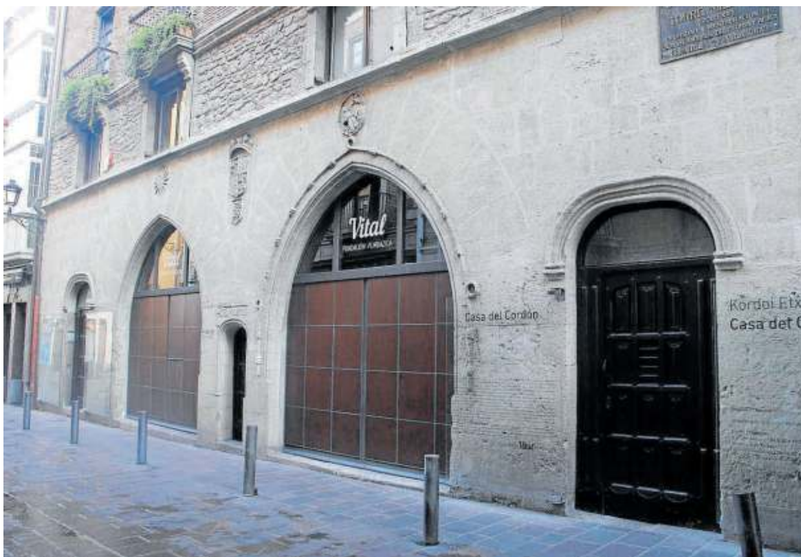
Fachada de la Casa del Cordón.
