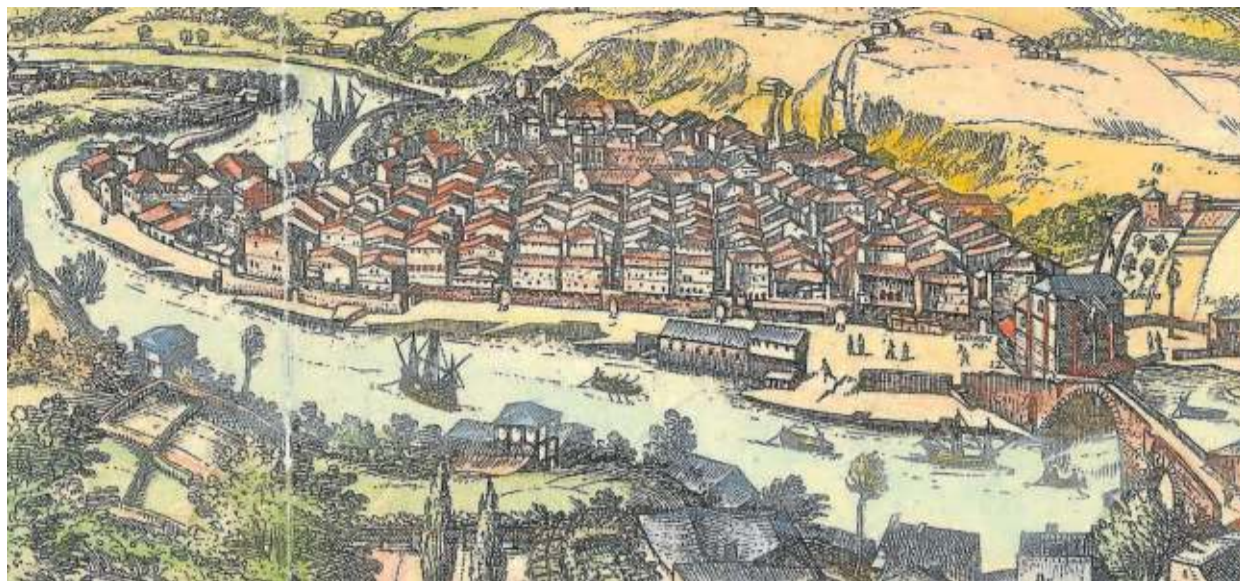
Vista panorámica de la villa de Bilbao con el puente de San Antón, la Casa de contar las Averías y la Ría.
