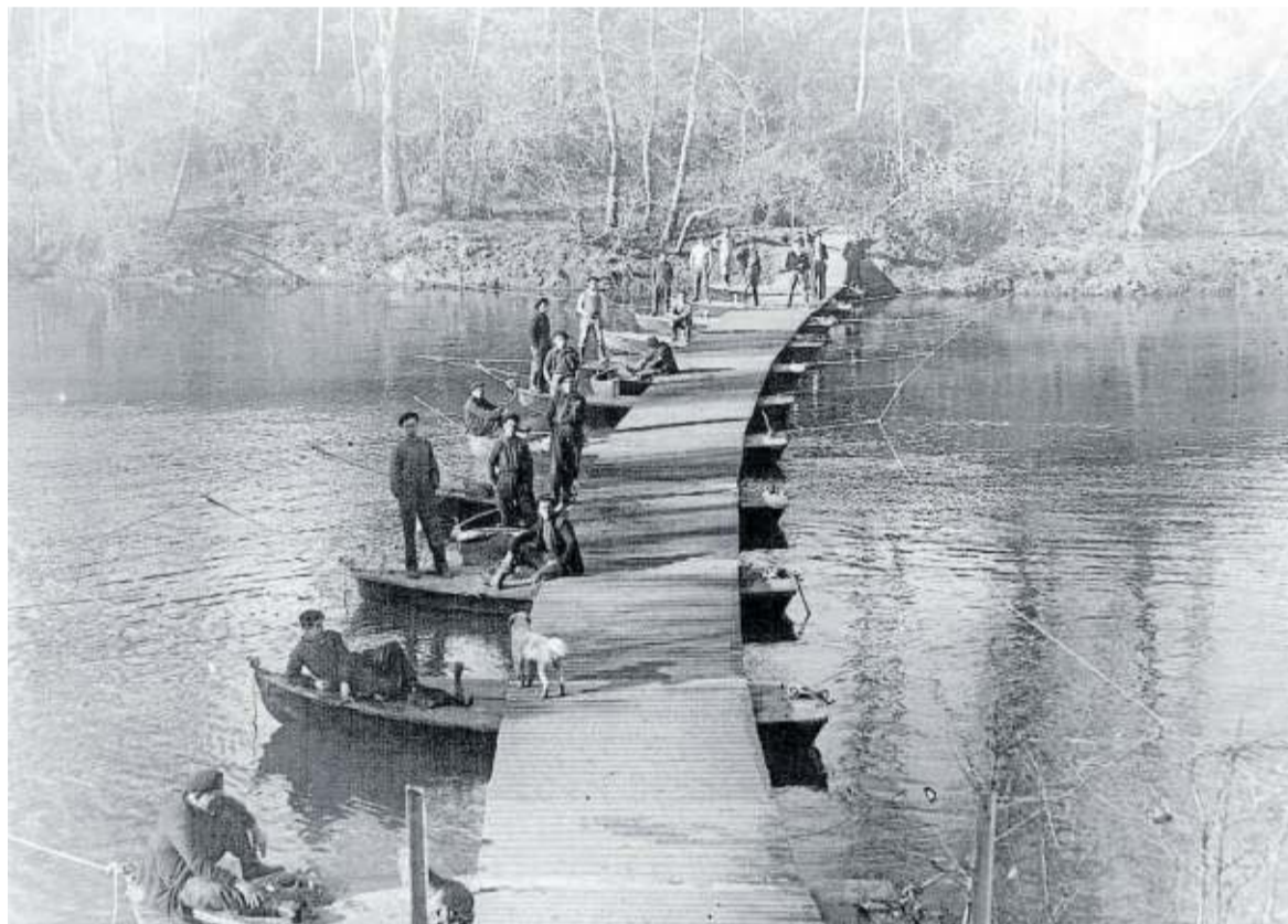
Puente de pontones sobre el río Nalón construido por la Sección de Zapadores del batallón ‘Eusko Indarra’. Foto: Museo Memorial del Cinturón de Hierro
